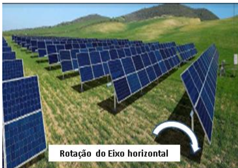
Figura 14 Rastreador Solar de Eixo Horizontal.
